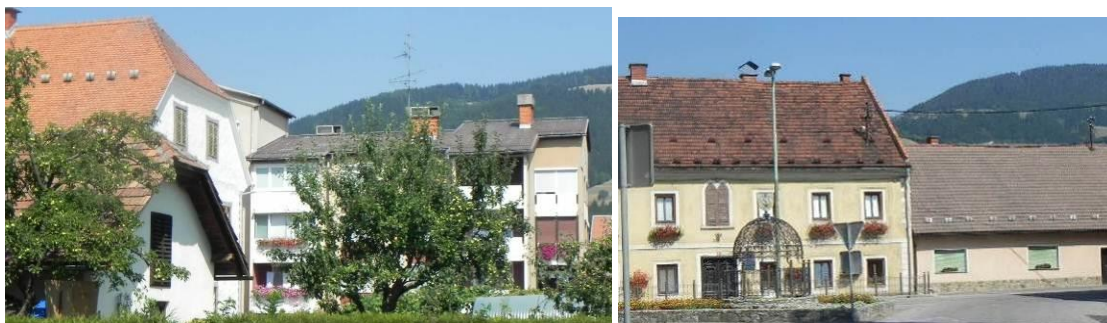
Slika 18: Primeri slabše gradnje ali prenove ob avtohtonih trških stavbah
