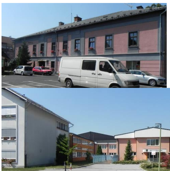
Slika 65: Prvotni dvorec danes javna stavba – občinska uprava in stavba osnovne šole zgrajene v različnih fazah in z različnim oblikovanjem, ki še upošteva vertikalni gabarit osrednjega dela naselja
