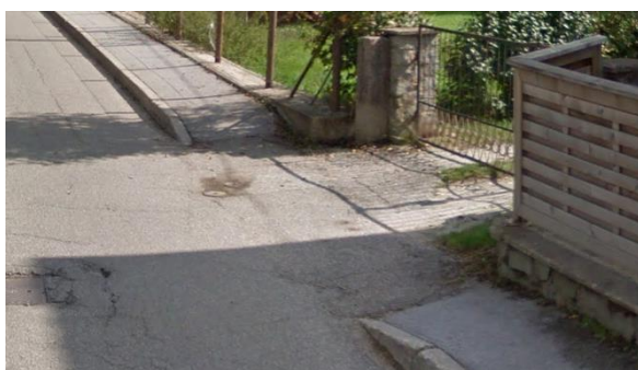
Slika 15: Levo – primer izvedenega spuščenega pločnika, desno - primer spuščenega robnika
